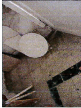
Particolare Interno Pavimento
