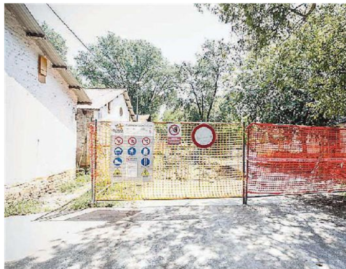
Il cantiere aperto a Forte Marghera
